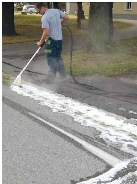
Es wurden von verschiedenen Firmen verschiedene Systeme vorgeführt und erprobt. Die mechanischen Verfahren haben den Nachteil, dass die Straßenoberfläche durch Abrieb in Mitleidenschaft gezogen wird. Weiters ist bei trockenem Wetter eine große Staubbelastung gegeben. Das Ergebnis ist nur als mäßig zu bezeichnen, da Unkräuter in Rissen und Fugen nicht gut erfasst werden.
