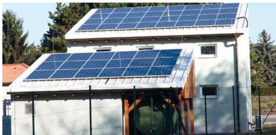
**Die Erneuerung der Kläranlage ist abgeschlossen. Für die Stromversorgung wurde eine 30 kW Peak Photovoltaikanlage installiert. Die Kläranlage entspricht jetzt den aktuellen Umweltstandards.**
